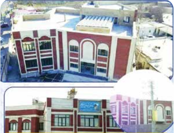
ساختمان شورای اسلامی شهر باغستان
