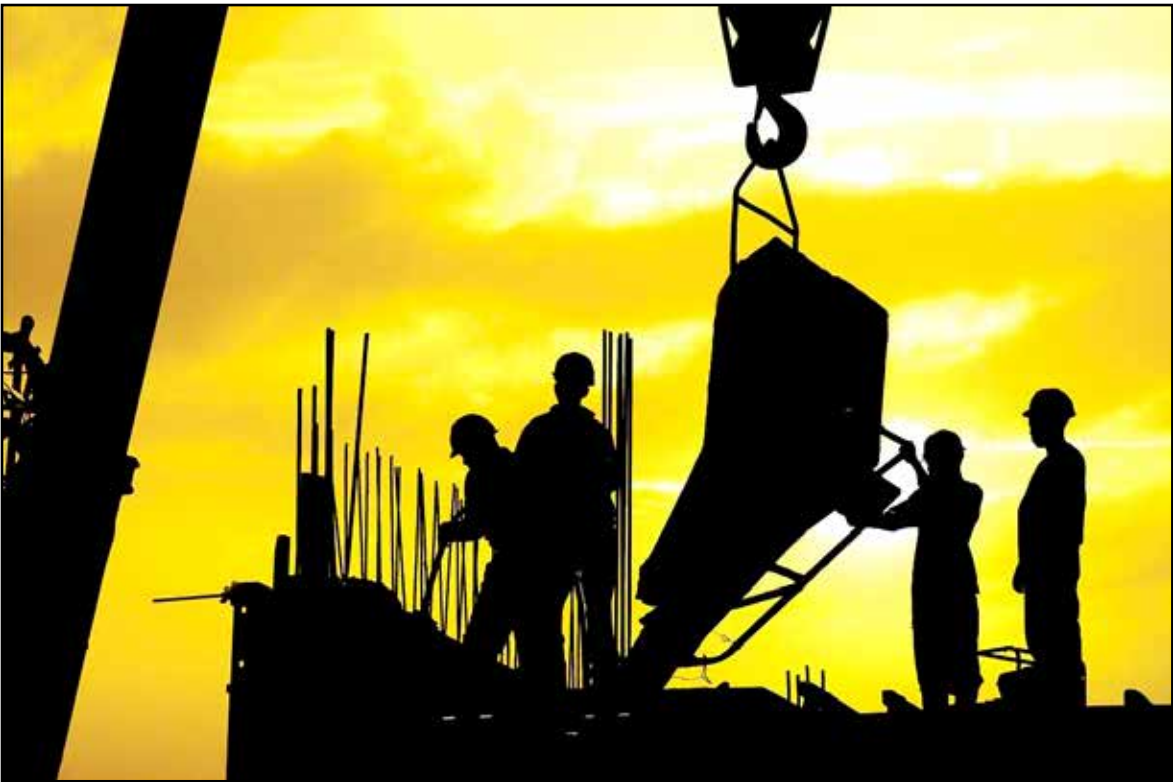
کارگران در حال ساختن یک ساختمان
