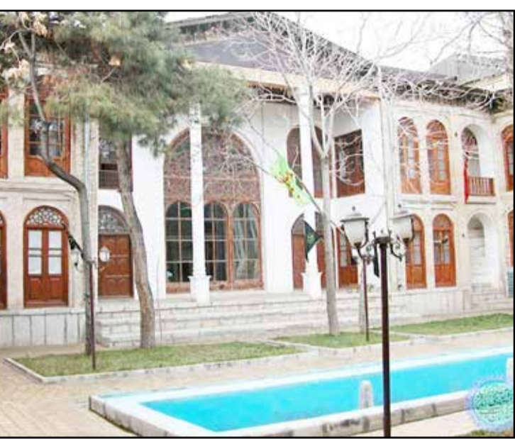
دوره قاجار را می توان اوج دوران ساخت تکایا در کرمانشاه قلمداد کرد. تکایایی که هنوز پس از گذشت سال ها معماری بی بدیلشان زیبا و چشم نواز هستند و از بناهای معاون الملک و بیگلربیگی می توان
