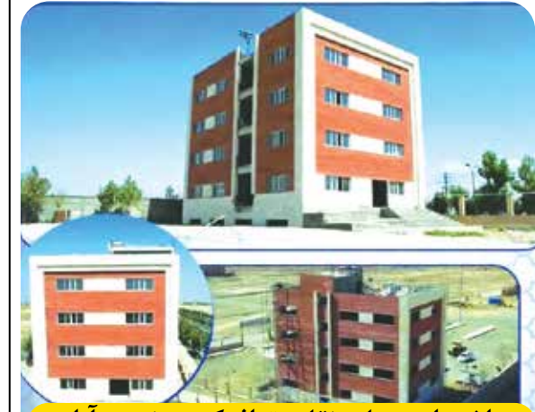
ساختمان حمل و نقل و ترافیک در نصیر آباد
