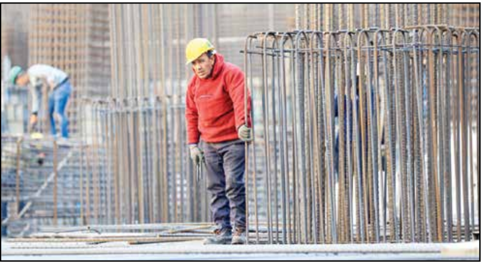
کارگر در حال کار بر روی اسکلت فلزی ساختمان.
